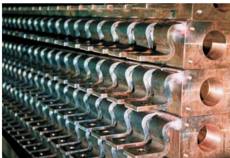
Abb. 75: Hochstrom-Leitungen für Verzinnungsanlage mit Innenkühlung.
